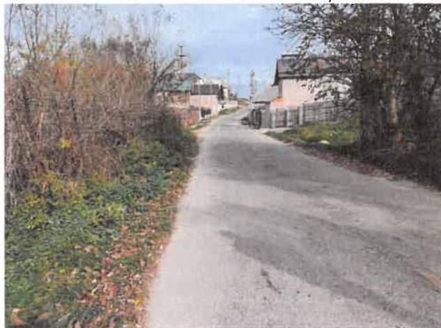
Acostamentele sunt tasate, denivelate, șanțurile sunt extrem de degradate
