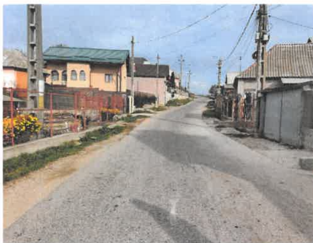
Acostamentele sunt tasate, denivelate, șanțurile sunt extrem de degradate
