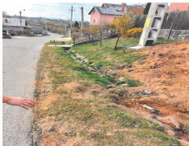
Acostamentele sunt tasate, denivelate, șanțurile sunt extrem de degradate
